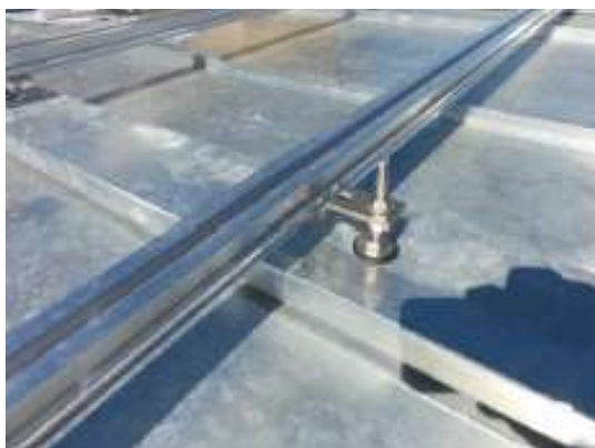
Abbildung 4: Befestigung der Solarpanels auf Leisten mit Stockschraubenbefestigung
